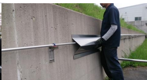
ガス配管設備工事
