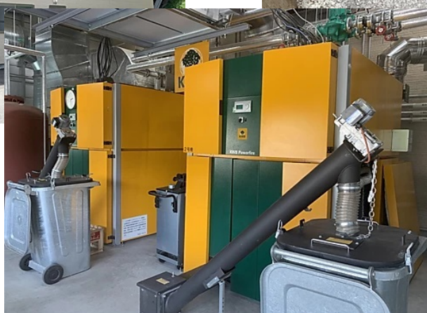
調査・選定等を行った高森町「御大の館・湯ヶ洞」の木質バイオマスボイラー
