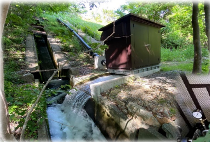
ユニット外装設置イメージ (20kwタイプ)
