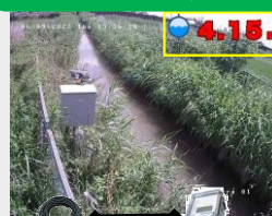
圧力式水位計 データロガー
