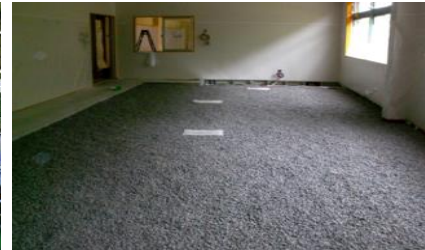
事務所に(施工写真)
